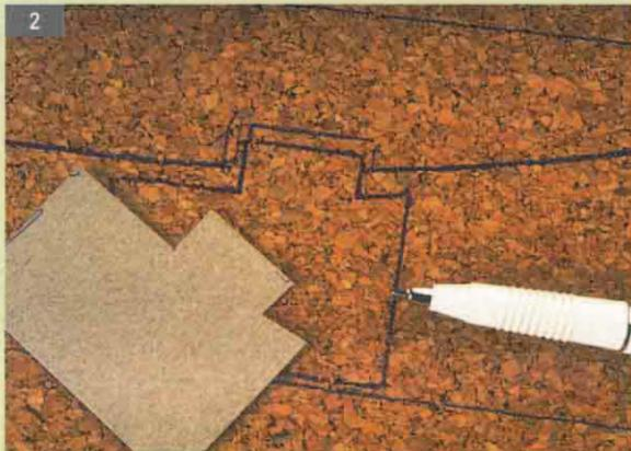
2. Die Position von Weiche und Schablone wird auf die Anlage übertragen.
