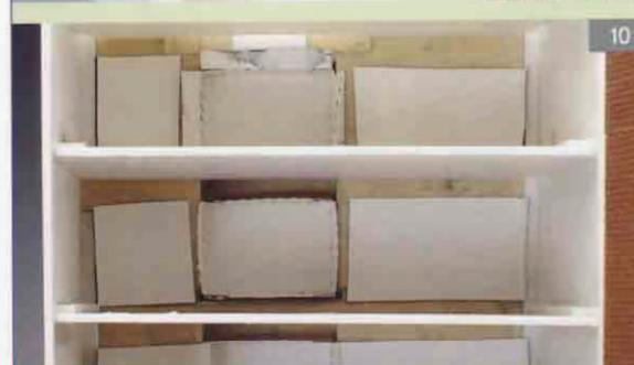
10. Einklebte Böden verleihen dem Gebäude die erforderliche Stabilität und sorgen dafür, dass die Wände sich später nicht verziehen können.
