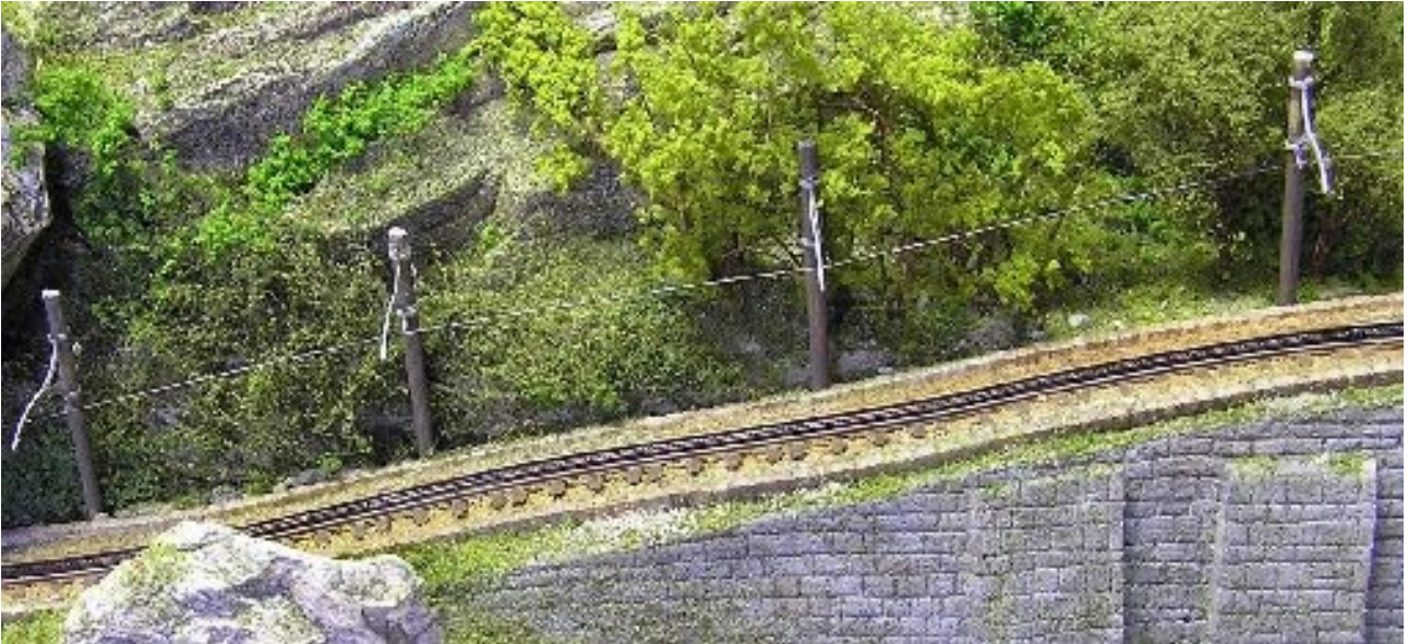
Streckengleis oberhalb der Hohen Mauer, mit typischen Holzmasten, SPB-Auslegern und Einfachfahrleitung
