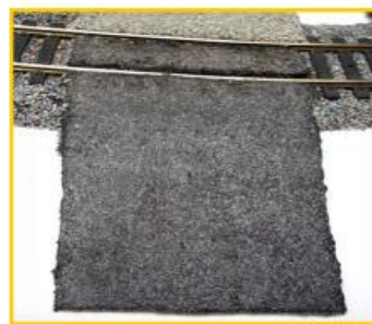
- Asfaltweg Gemaakt met ER-QUICK spoorbedding
