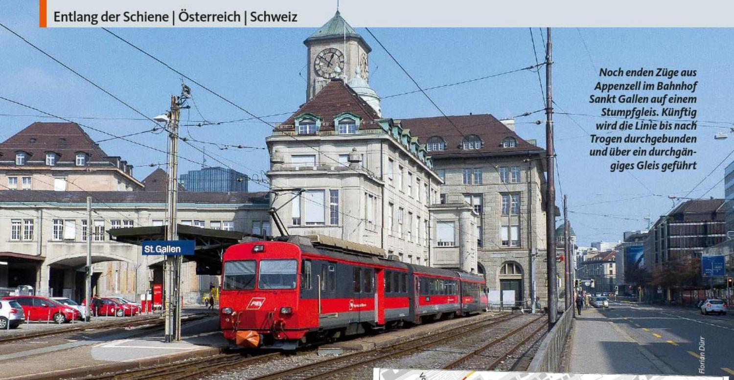
Noch enden Züge aus Appenzell im Bahnhof Sankt Gallen auf einem Stumpfgleis. Künftig wird die Linie bis nach Trogen durchgebunden und über ein durchgängiges Gleis geführt
