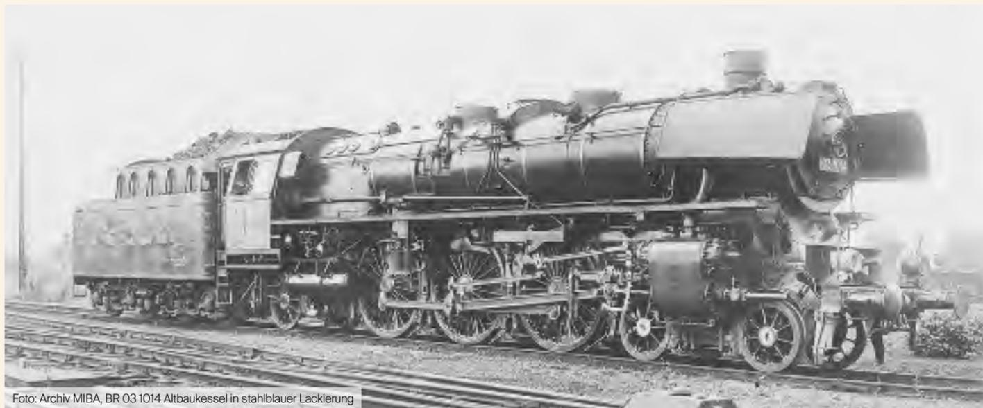
Foto: Archiv MIBA, BR 03 1014 Altbaukessel in stahlblauer Lackierung
