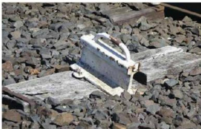
permettant d'y introduire une sonde qui mesure la température au « cœur » du métal et, par déduction, la température de la voie à côté de laquelle il est posé. Ces coupons sont-ils courants? Peu employés? Pour ma part, je les découvre, comme ce sera peut-être le cas pour d'autres lecteurs de la revue...
