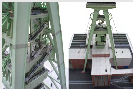
Schacht 2 der Zeche Lohberg in Dinslaken
