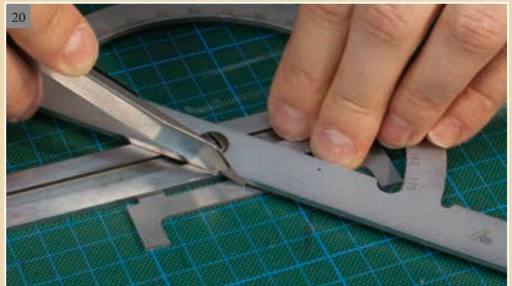
Das übrige Teil der Bodenplatte mit Stufe muss im 45° Winkel gekürzt werden. Aus dem Rest schneidet man ein weiteres Teil mit 45° Winkel für den Giebel.
