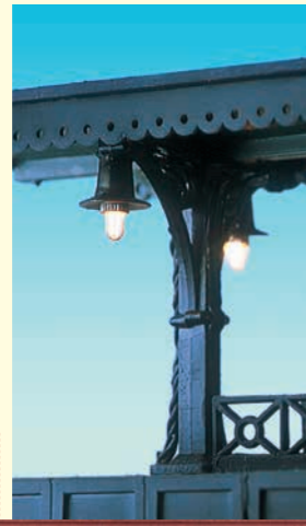
Bahnsteigbeleuchtung Platform Light
