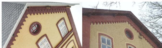
Výpravní budova Bohdašín Bahnhofsgebäude Bohdasin
