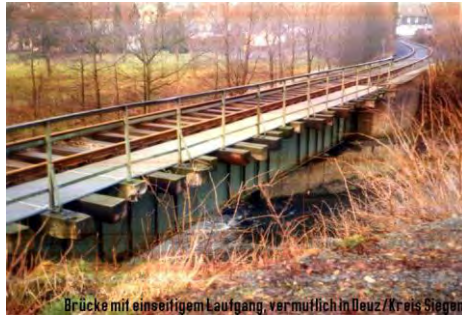
Brücke mit einseitigem Laufgang, vermutlich in Deuz/Kreis Siegen
