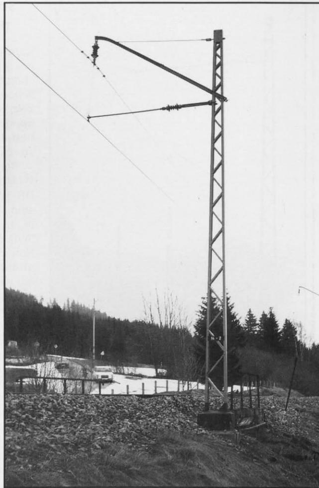
▲ Zwei Abspannmasten auf einer Reichsbahnstrecke, Anfang der vierziger Jahre schon mit Y-Beiseil. Beim Mastenpaar im Hintergrund Gitterkonstruktion im oberen Drittel wegen Materialersparnis vereinfacht.
