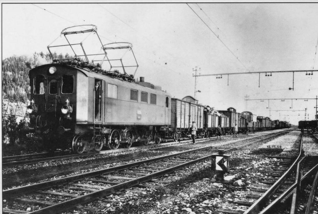
Bild Oben: In der Frühzeit der deutschen Bahnelektrifizierung hängte man die Oberleitungen in den Bahnhöfen an Portalen aus Stahlprofilen auf. In der Regel handelte es sich um zierliche Konstruktionen. Die doppelten Traversen erhielten einen Unterzug aus Stahlseilen. Die Seitenhalter waren an den Masten oder an den zugleich der Festigkeit des Portals dienenden Hängestäben befestigt.
